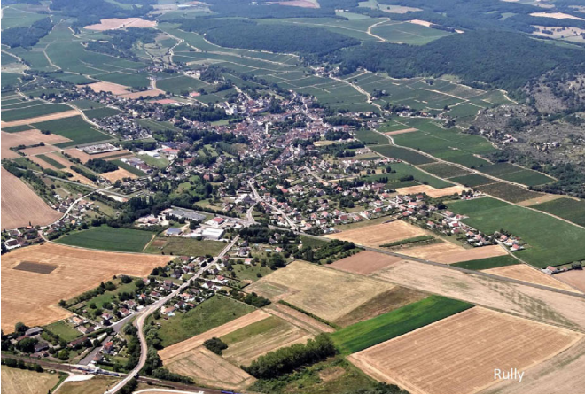
Préserver la silhouette groupée des villages. Éviter d'enclaver des terres agricoles dans l'urbanisation. S'inspirer du bâti existant et favoriser l'alignement des façades et la mitoyenneté qui font le charme des centre-bourgs.
