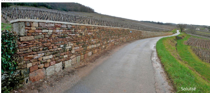
Entretien des murs de soutènement en pierre le long des routes et des chemins.
