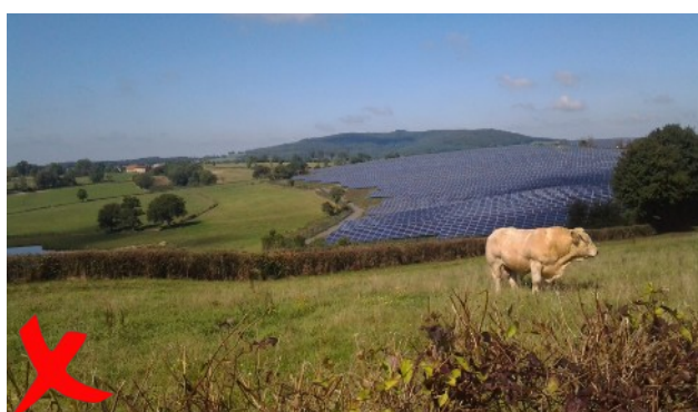
Installation PV à Chalmoux, 1er parc PV du département : très visible, même de loin.
