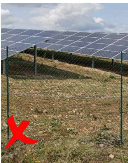
Clôture simple torsion peu durable
