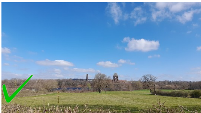
Installation PV à Epinac, placé en contre-bas, il est peu visible depuis les routes.
