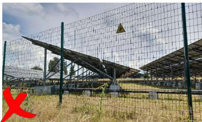
Figure 3: les plots en béton sont parfois nécessaires (sols pollués par exemple) mais ils sont à éviter.
