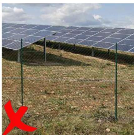
*Figure 9: Clôture simple torsion peu durable.*
